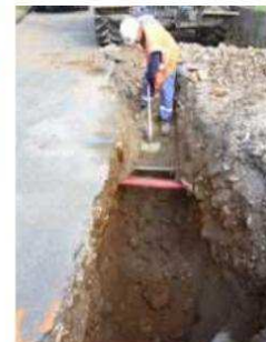
Les travaux rue Gaston-de-Foix dureront encore toute la semaine. PHOTO MARIE
